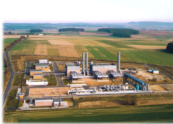
Figura 1.6: Estación de compresión.
